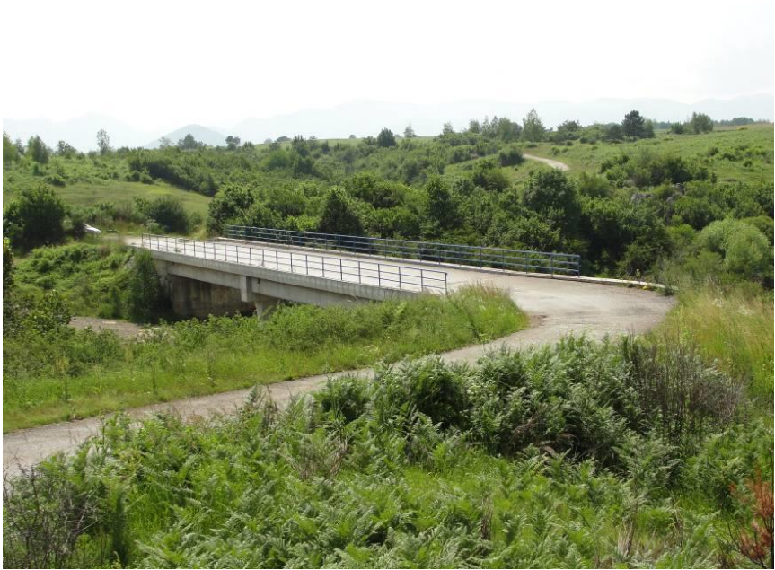
Slika 4: Prikaz rekonstruiranog mosta preko rijeke Like kod Gospića
